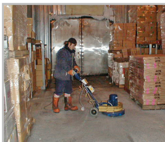
▲ 冷凍倉庫床の氷の除去
