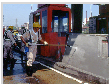
▲ コンクリート壁の汚れ落とし
