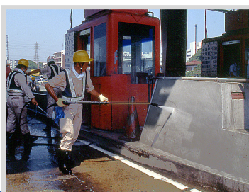
▲ コンクリート壁の汚れ落とし
