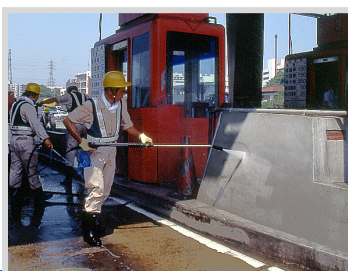
▲ コンクリート壁の汚れ落とし
