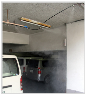
▲地下駐車場出入り口に
