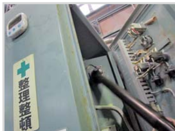
▲配電盤内部の掃除
