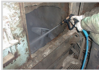
▲生コン・バッチャープラントの洗浄
