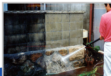
...壁面の汚れもきれいに落とします。
